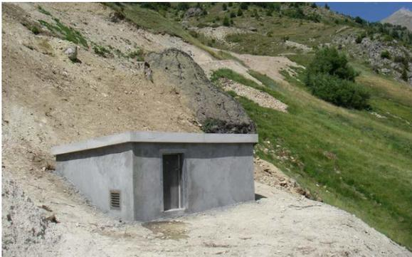
Une fosse septique a déjà été installée pour la cabane du Bois Noir, les raccordements devraient être terminés au printemps prochain.
